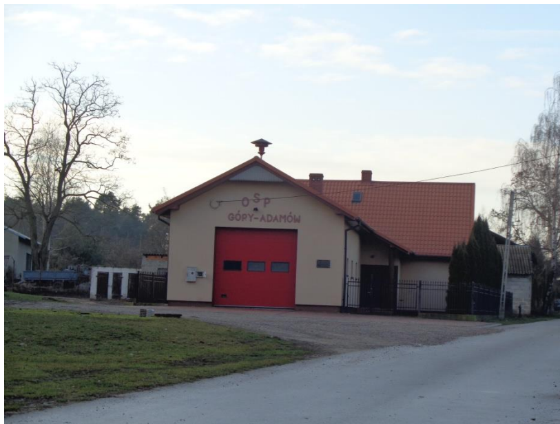
Fot. 13. Budynek Ochotniczej Straży Pożarnej w miejscowości Góry Adamów. G. Ferliński, 2020 r.
