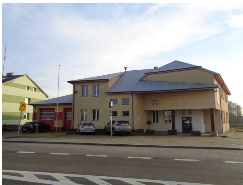
Fot. 12. Budynek Ochotniczej Straży Pożarnej w miejscowości Promna-Kolonia. A. Pustowska, 2020 r.
